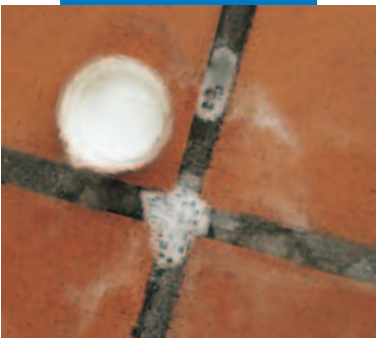
Pulizia di efflorescenza
