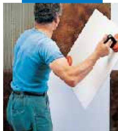
Posa di KERAION a parete
