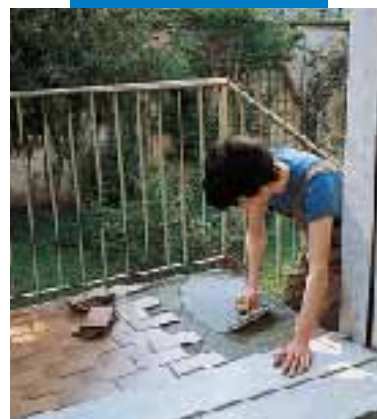
Rasatura impermeabilizzante e successiva posa con Kerabond + Isolastic
