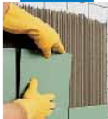
Posa su vecchie piastrelle
