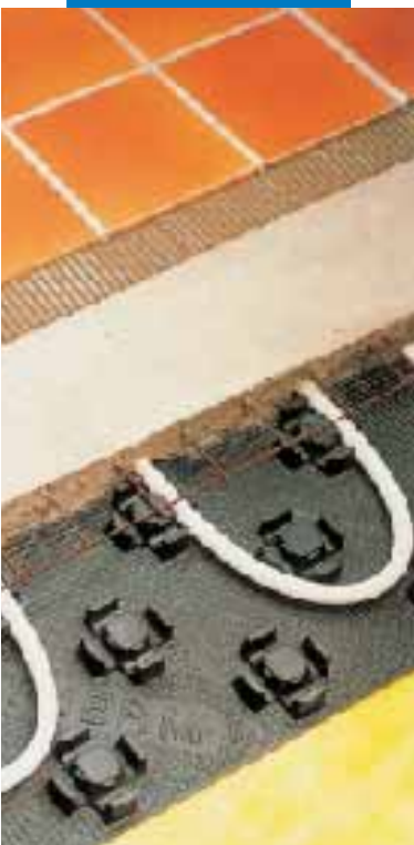
Posa di ceramica su pavimenti riscaldanti
