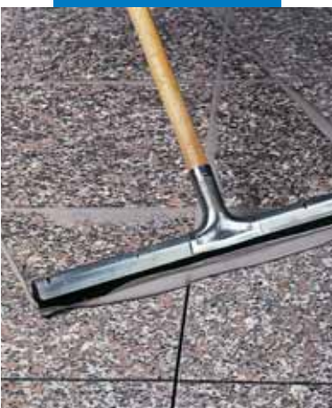
Stuccatura di pavimento in granito prelevigato con racla
