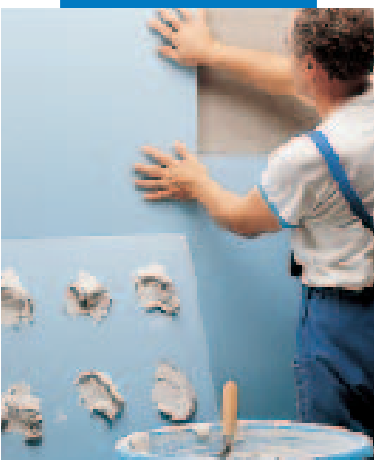
Posa di lastre di polistirolo con Keraflex bianco
