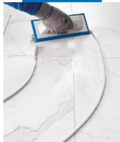
Stesura di Ultracolor Plus a pavimento con spatola di gomma su piastrelle in gres porcellanato effetto marmo
