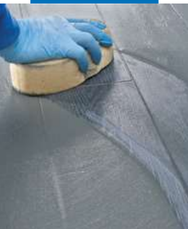
Pulizia e finitura delle fughe con spugna di cellulosa dura
