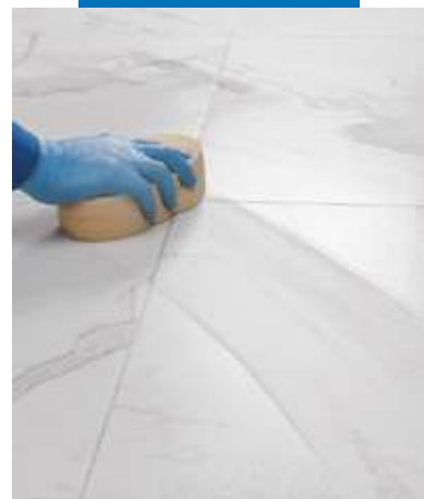
Pulizia e finitura delle fughe con spugna di cellulosa dura
