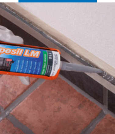
Sigillatura di rivestimento in pietra in interno
