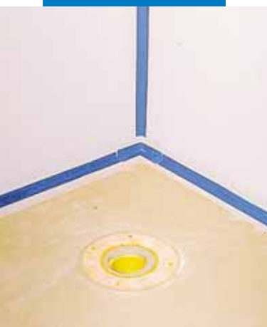
Impermeabilizzazione delle pareti di un bagno realizzata con Mapegum WPS e Mapeband
