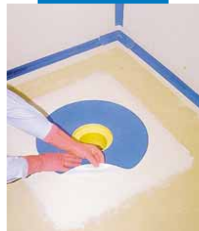
Posizionamento del pezzo speciale di Mapeband su Mapegum WPS
