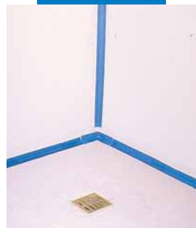
Impermeabilizzazione con Mapegum WPS e Mapeband completata
