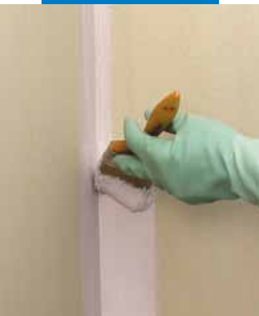
Applicazione a pennello di Mapegum WPS
