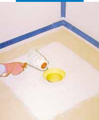
Stesura di Mapegum WPS in prossimità della bocchetta di scarico della doccia
