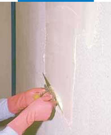
Stesura di adesivo su Mapegum WPS
