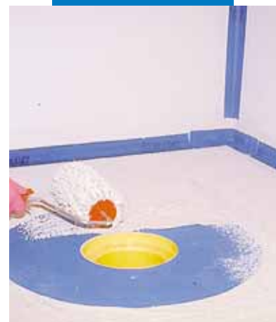
Il pezzo speciale di Mapeband viene annegato nel Mapegum WPS
