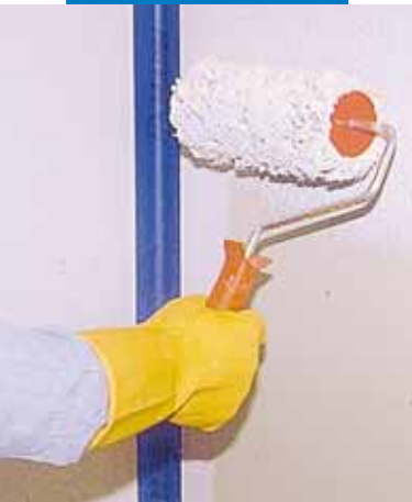
Applicazione di Mapegum WPS a parete con rullo
