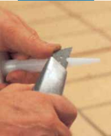
Tagliare l'ugello in base alle dimensioni del giunto
