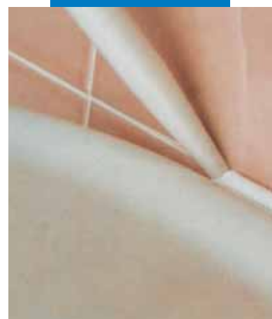
Sigillatura di sanitari
