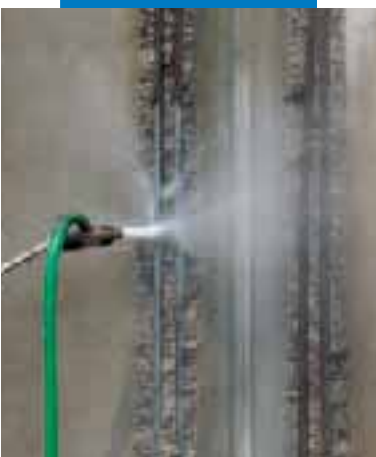
Pulizia dei ferri con idrosabbatura
