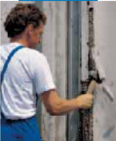
Demolizione del calcestruzzo degradato
