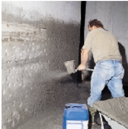
Applicazione a spruzzo del 1° strato di malta additivata con IDROSILEX LIQUIDO
