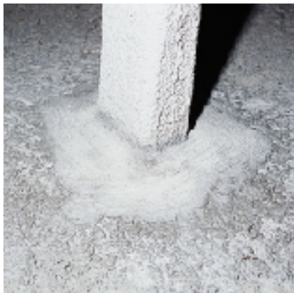
Esempio di pilastro impermeabilizzato con IDROSILEX
