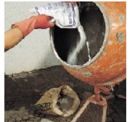
Preparazione della malta idrofuga additivata con IDROSILEX POLVERE
