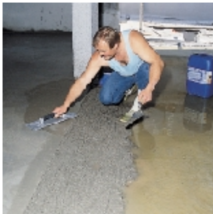
Applicazione del battuto di pavimento additivato con IDROSILEX LIQUIDO
