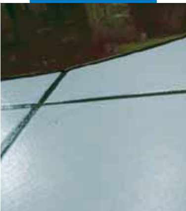
Particolare dell'applicazione di Ultraplan su pavimento in ceramica esistente previa applicazione di Mapeprim SP
