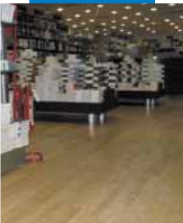
Esempio di posa di legno effettuata su livellatura in Ultraplan - Messaggerie Musicali - Roma - Italia
