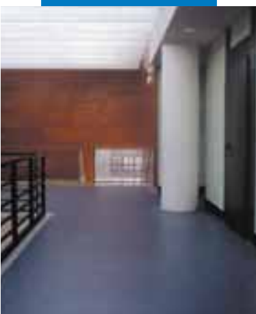
Esempio di posa di linoleum effettuata su livellatura in Ultraplan - Conservatorio di Monzón - Spagna
