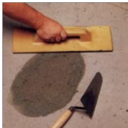
Rappezzo di pavimento: lisciatura finale
