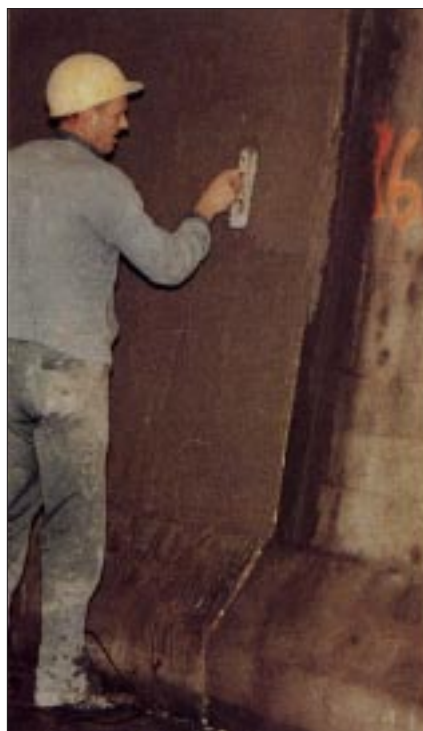
Intonaco cementizio con PLANICRETE. Cantiere Tunnel autostradale Ville Marie Montreal - Canada
