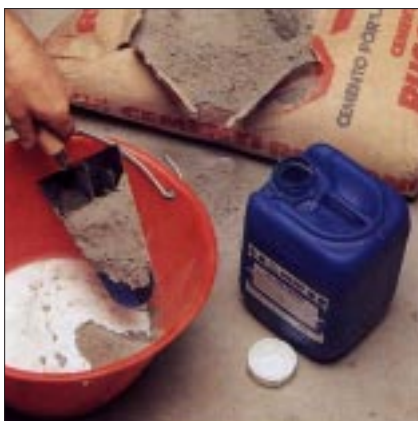
Miscelazione di malta cementizia con PLANICRETE
