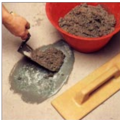
Rappezzo di pavimento: applicazione malta
