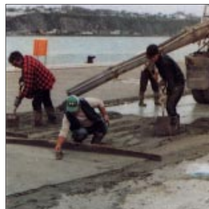
Pavimento esterno con calcestruzzo modificato con PLANICRETE. Cantiere Vieux Port, Quebec, Canada
