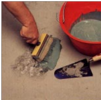
Rappezzo di pavimento: applicazione boiaccia
