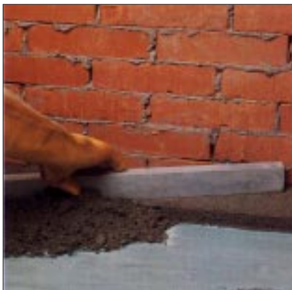
Applicazione di massetto cementizio aderente modificato con PLANICRETE
