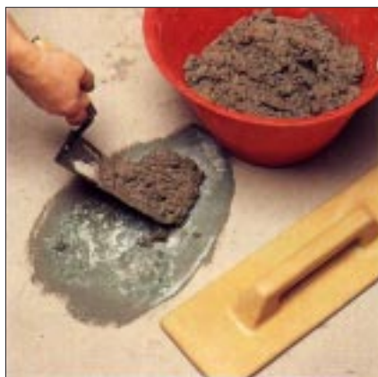
Rappezzo di pavimento: applicazione malta
