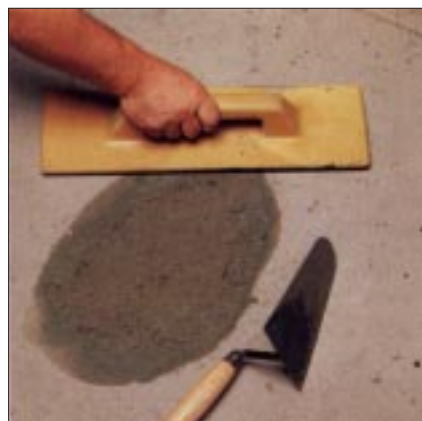
Rappezzo di pavimento: lisciatura finale
