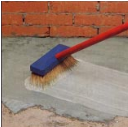
Applicazione di boiacca cementizia adesiva modificata con PLANICRETE
