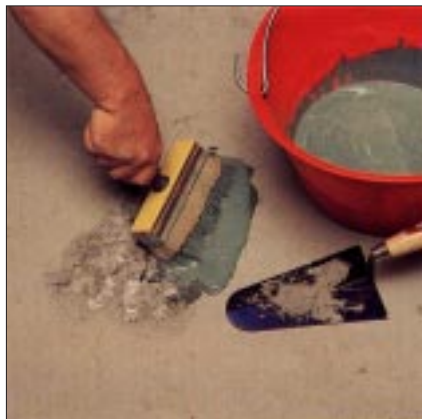
Rappezzo di pavimento: applicazione boiaccia
