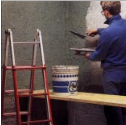
Rinzafo adesivo additivato con PLANICRETE
