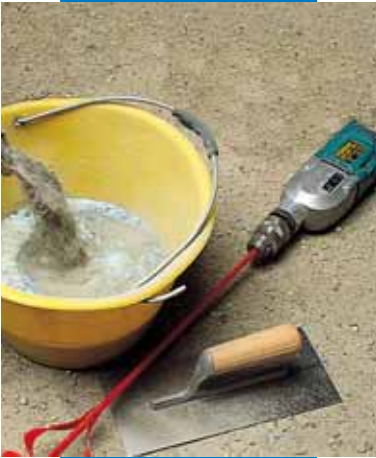
Impasto di Mapelastic con agitatore meccanico
