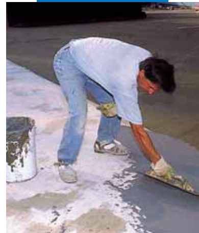
Impermeabilizzazione di una piscina con Mapelastic
