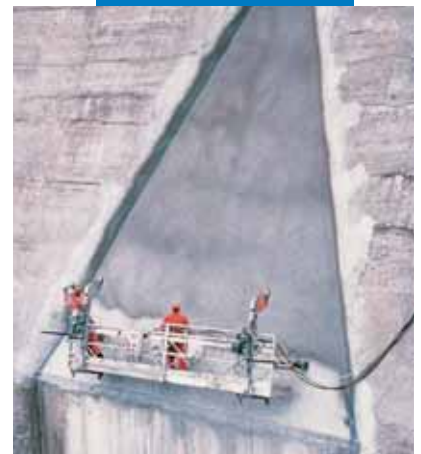
Esempio di applicazione a spruzzo di Mapelastic in una diga
