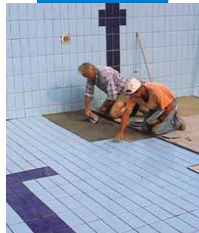
Posa di rivestimento ceramico su Mapelastic
