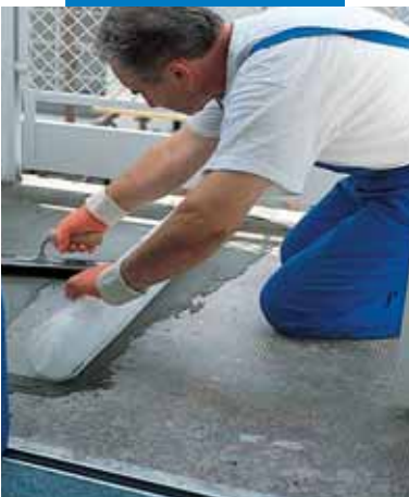
Impermeabilizzazione di un balcone con Mapelastic con applicazione di una rete di rinforzo in fibra di vetro
