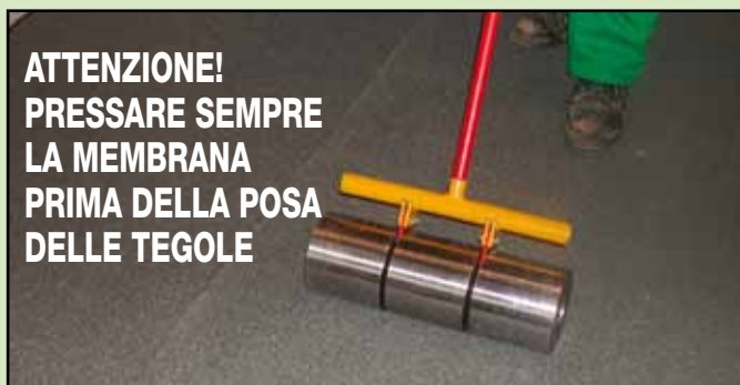
8. Pressatura generale prima della posa delle tegole
