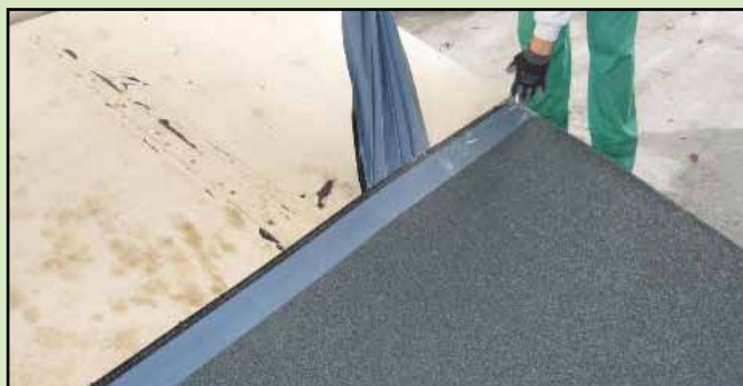
2. Incollare per autoadesione la membrana
