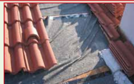
8. Pressatura generale prima della posa delle tegole
