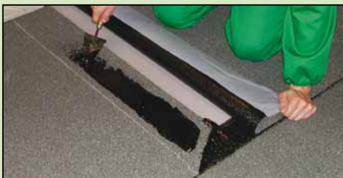
7. Saldare le sovrapposizioni di testa con HEADCOLL
