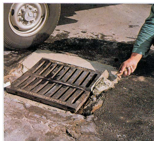
Posa di un chiuso stradale
