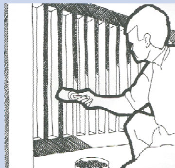
Protezione di ringhiere metalliche
