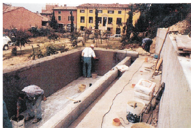
Impermeabilizzazione di piscina con ANTOL AQUAPROOF al NEOPLAST LATEX
