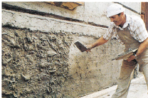
Regolarizzazione di supporto murario con malta al NEOPLAST LATEX
